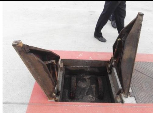
Ultimata l'attività di carico dell'aeromobile si può procedere con lo sblocco del sistema anti-tipping e la chiusura dei pozzetti interessati.
