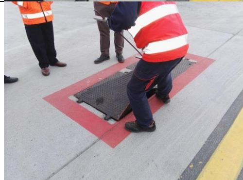
Una volta sollevato e bloccato il primo petalo (abbassando l'apposito fermo nel tramite della chiave in dotazione) procedere con il sollevamento del secondo, utilizzando l'altra estremità della chiave.
